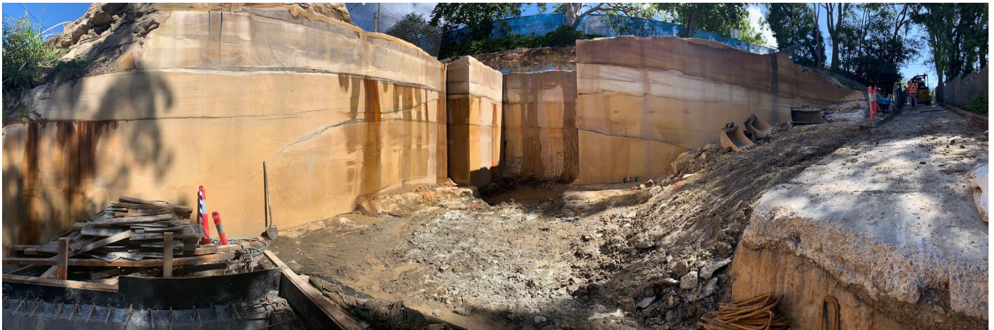
Image: Excavation detail on Como Parade, April 2021
